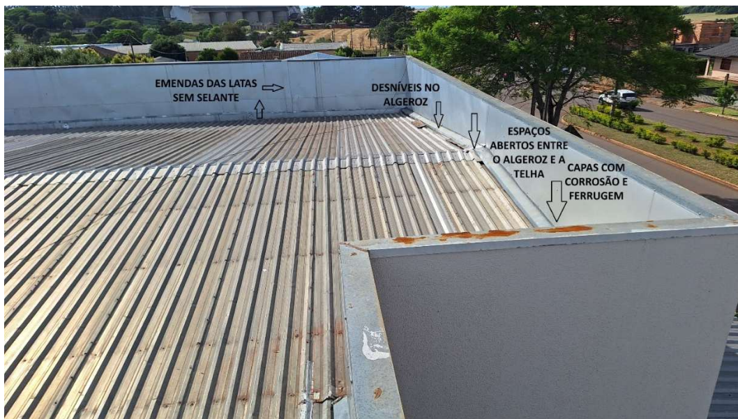
Imagem 16: Foto das capas e algeroz da fachada frontal do plenário.
