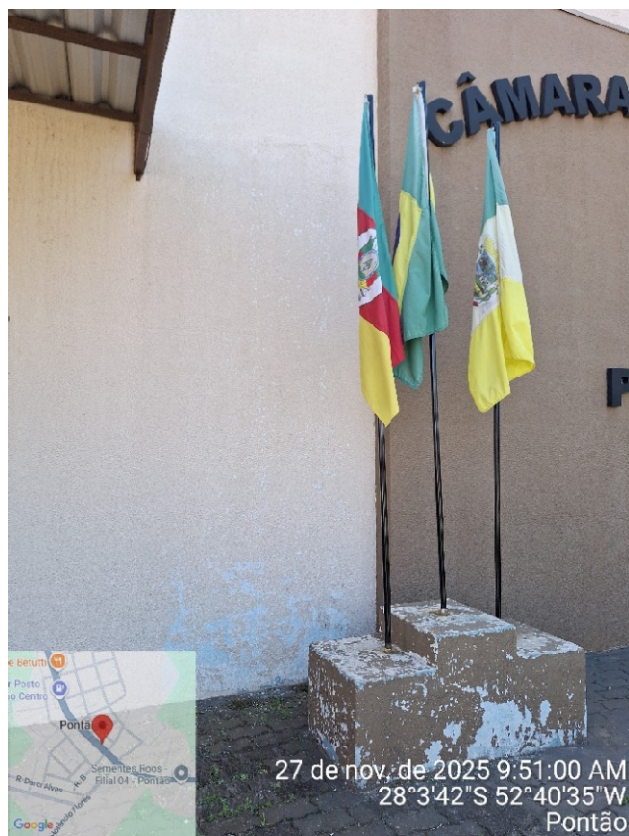
Imagem 28: Foto das texturas na fachada frontal.
