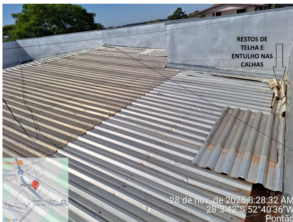
Imagem 9: Foto das calhas sobre o telhado do plenário.
