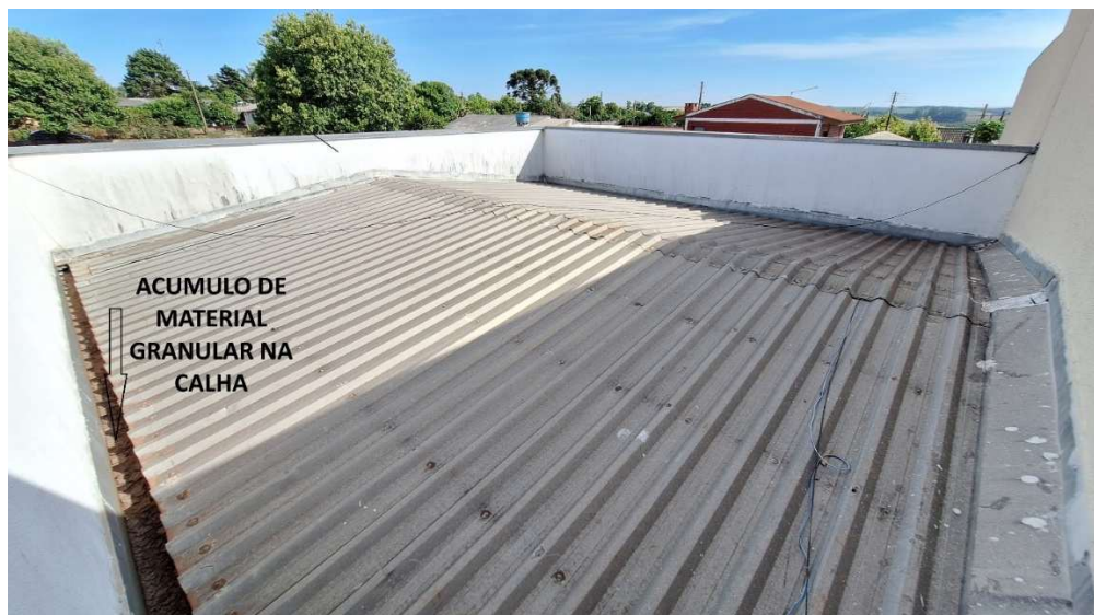
Imagem 6: Foto das calhas sobre o telhado do administrativo.
