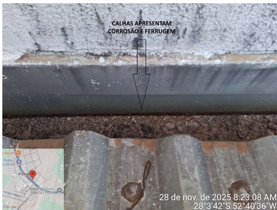
Imagem 7: Foto das calhas sobre o telhado do administrativo.
