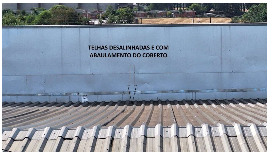
Imagem 12: Foto do telhado sobre o plenário.
