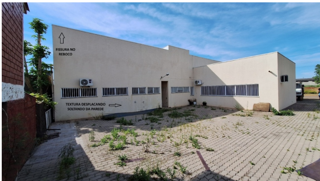
Imagem 24: Foto da textura da fachada norte (fundos).
