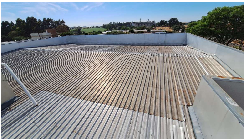
Imagem 10: Foto do telhado sobre o plenário.
