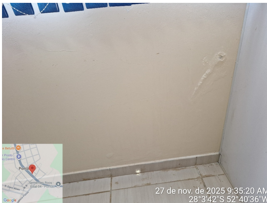
Imagem 30: Foto das paredes na sala de reunião.
