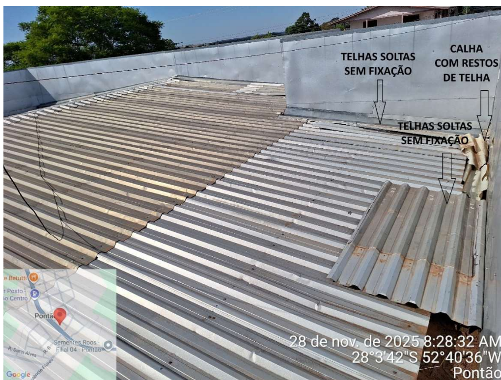
Imagem 14: Foto do telhado sobre o plenário.
