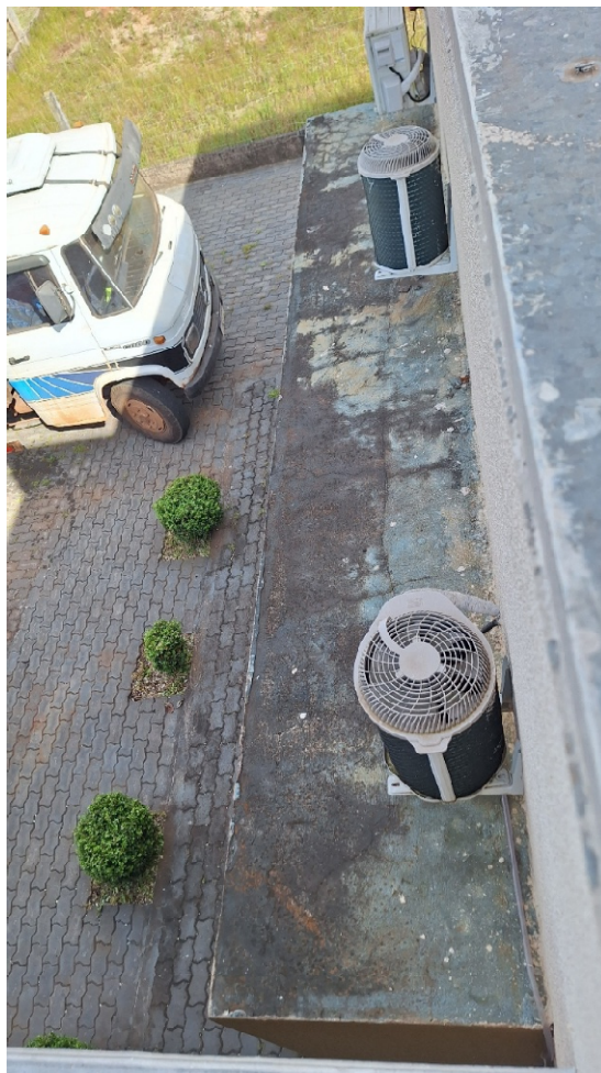
Imagem 21: Foto da laje de cobertura na fachada do administrativo.
