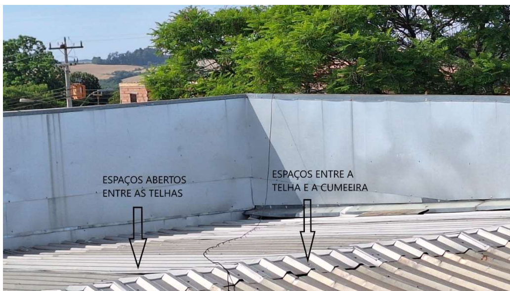
Imagem 11: Foto do telhado sobre o plenário.
